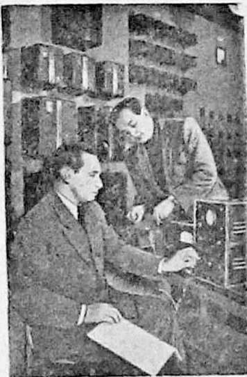
Рига. Коллектив «Латвэнерго» проводит телемеханизацию электростанций и электроподстанций. Кегумская ГЭС переведена на телеуправление из центрального диспетчерского пункта. С помощью телемеханики производится пуск и остановка гидроагрегатов.
